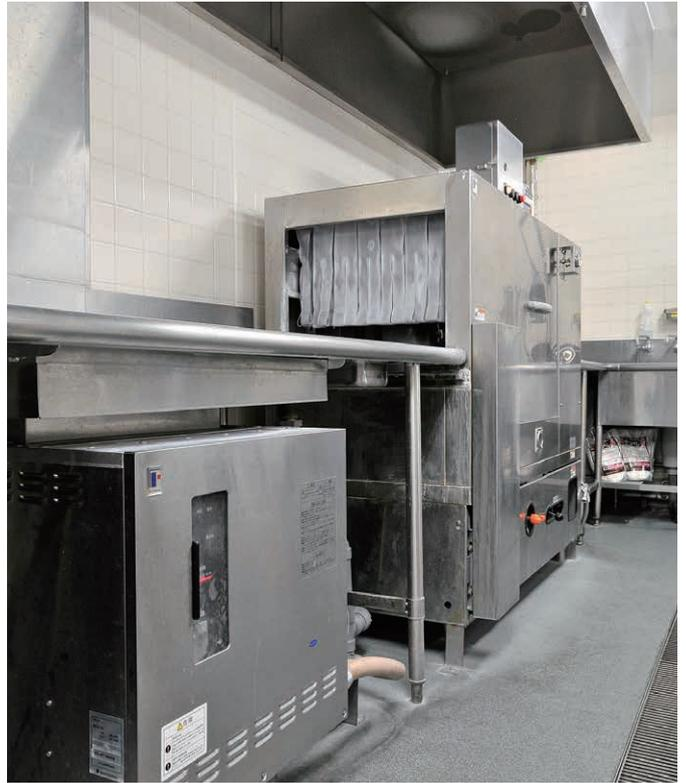
ラックコンベアタイプ洗浄機には、熱効率に優れ、安定した仕上げ給湯が行なえるガス式ブースターを設置
